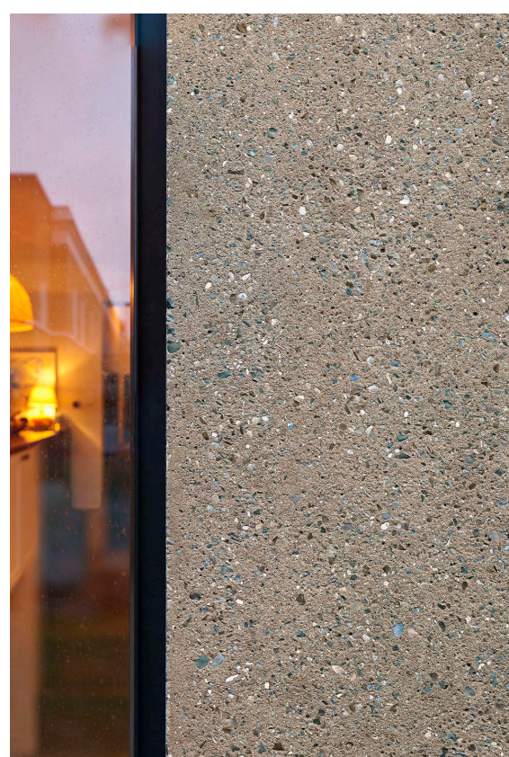
BETONSKI PREBRIKAT cjelovito oblaganje pročelja prizemlja (ulično i dvorišno naličje te kolni prilaz)
