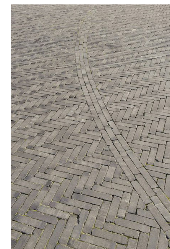
PODNA OPEKA uređenje partera dvorišta
