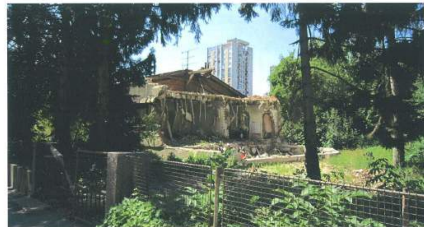
POSTOJEĆA STAMBENA GRAĐEVINA FROUDEOVA ULICA 2-4 - ZAPOČETO UKLANJANJE
