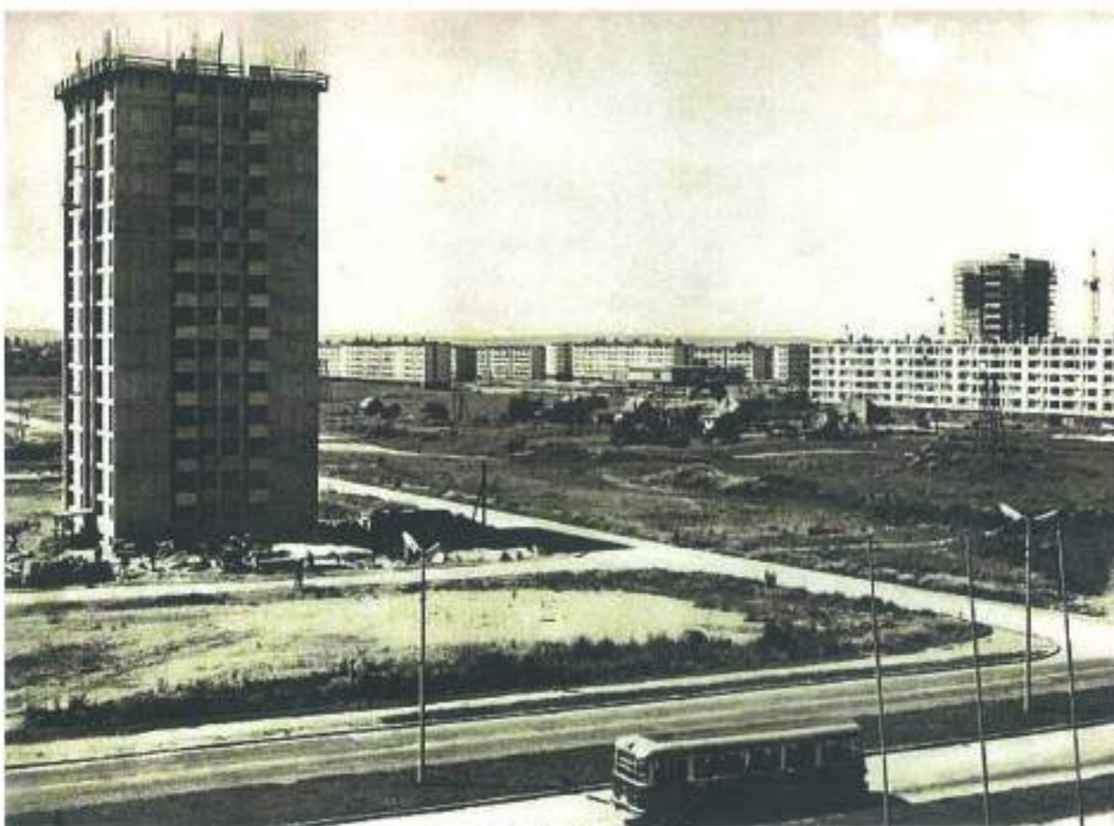
SIGET – POČETAK GRADNJE
